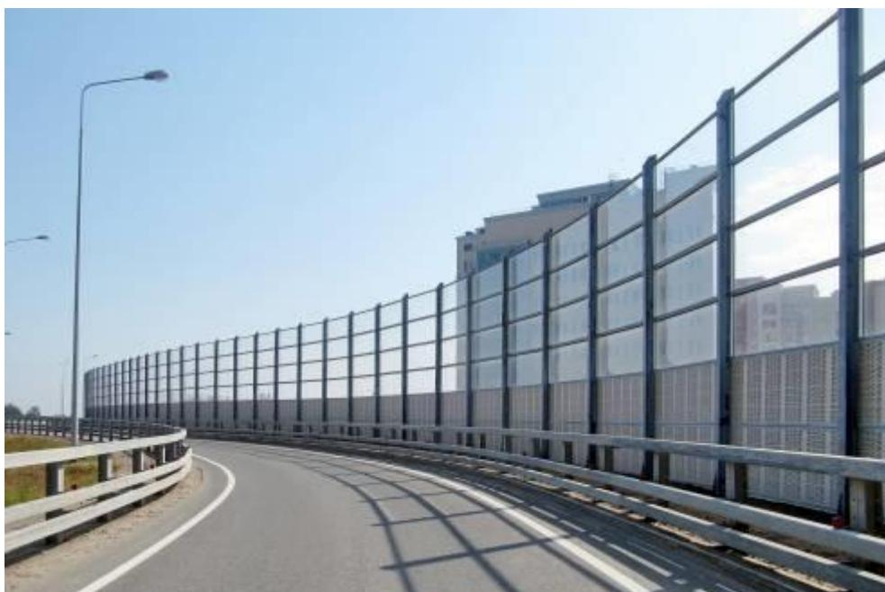
**Рисунок 6. Защитное ограждение «защитный экран».**
